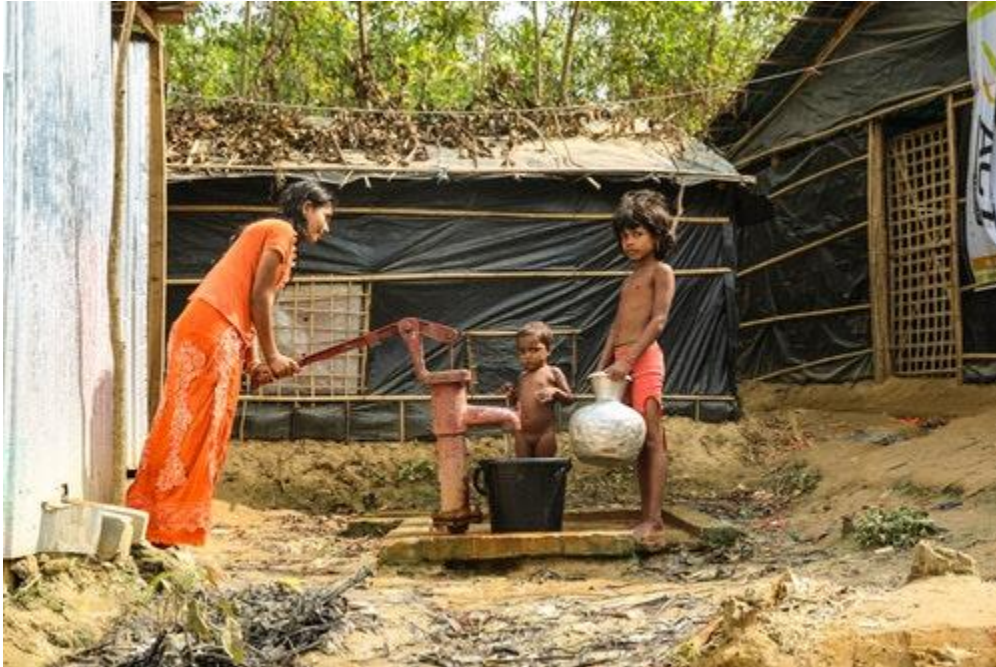
Les latrines et les pompes à eau sont au même niveau, ce qui augmente les risques de contamination.
